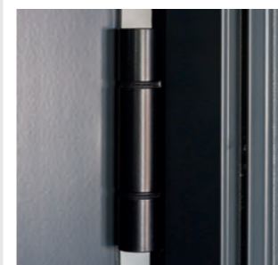
Sash & Jamb Hinge
